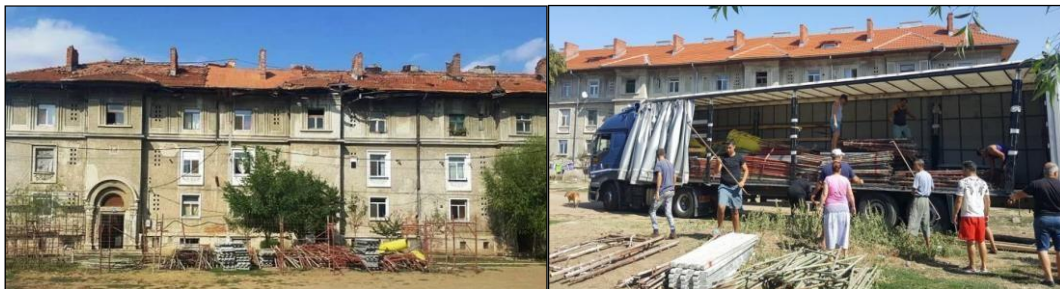
Foto: repararea acoperisului blocului ghetou din Aleea Carpati, Caracal
